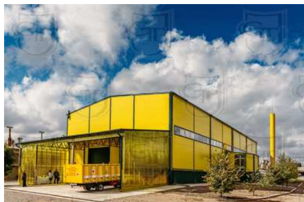
Производство по переработке медицинских отходов
